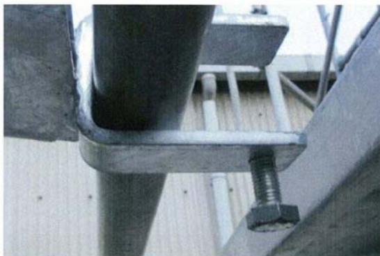
4.最後に抜け止めのボルトを締めて完了。勝手違いの時にはボルトが上に向きます。
