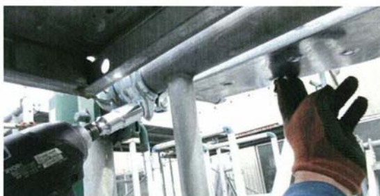
3.三角ステップ本体の先端を軽く支え、クランプをインパクトレンチで締める。
