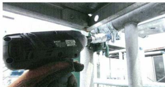
3.三角ステップ本体の先端を軽く支え、クランプをインパクトレンチで締める。
