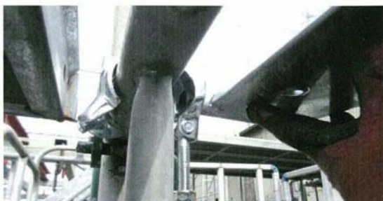
2.クランプを建枠の横架材に上からかぶせて下さい。
