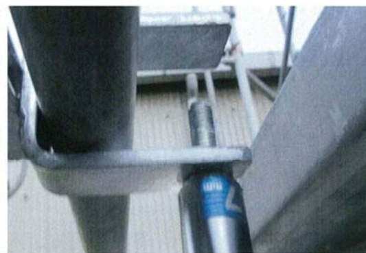
4.最後に抜け止めのボルトを締めて完了。勝手違いの時にはボルトが上に向きます。
