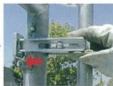
下部固定金具の先端の孔にクサビを差し込む
