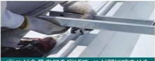
③ハゼ金具の口を広げて、ハゼ部に咬ませるようにセットする。(ハゼ金具4ヶ所)
