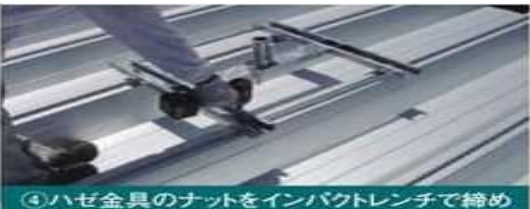
④ハゼ金具のナットをインパクトレンチで締め込み固定する。(ハゼ金具4ヶ所)
