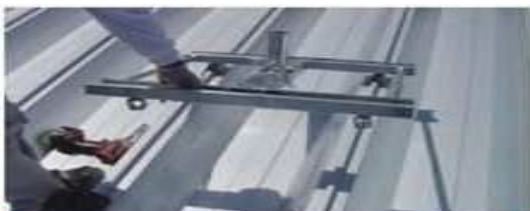
①支柱ベースを仮置きする。その時に、ハゼ金具のナットをインパクトレンチで緩めておく。
